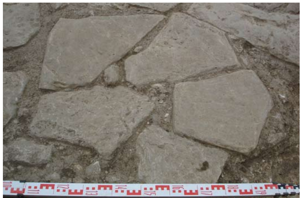
Figura 3 Fotografia de pormenor das lajes da estrada.
