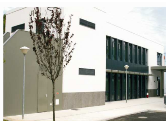
Foto 14 - EB2,3 D. António Ataíde – Castanheira do Ribatejo – obras de ampliação
