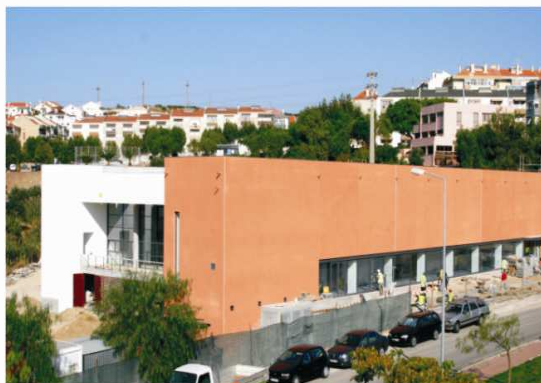
Foto 17 – Piscina Municipal do Forte da Casa
