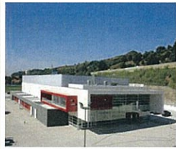
Construção do Pavilhão Multifusos
