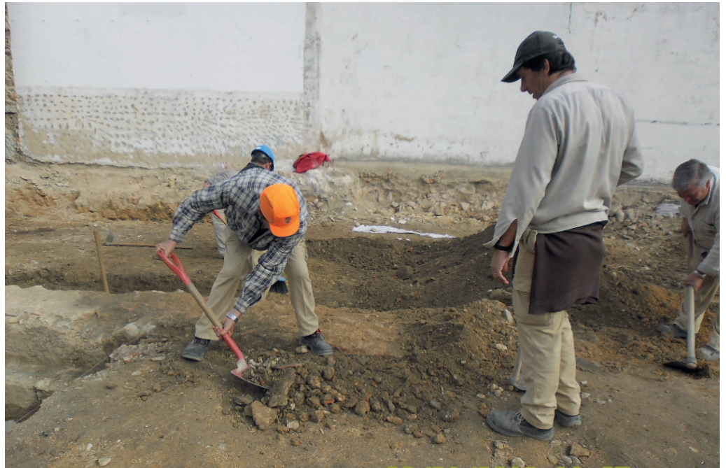
Figura 10 Início dos trabalhos de limpeza da área de intervenção.
