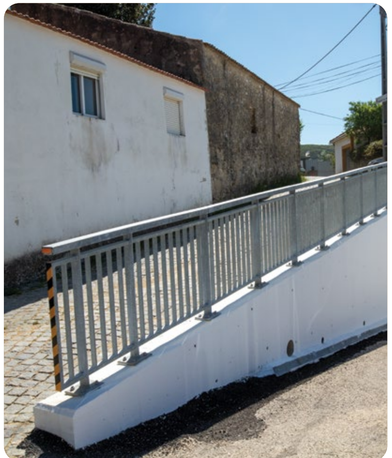
Muro na Rua dos Combros - Calhandriz - 90.100,00 €
