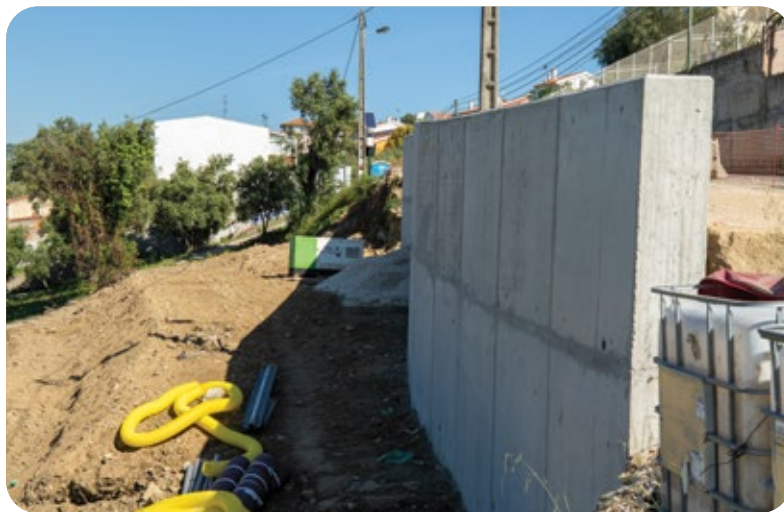
Talude da EN 248 - 3 (Casal do Álamo) - 157.465,00€
