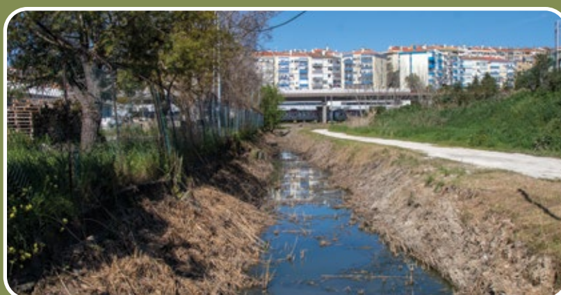
Vala paralela à estação elevatória - Póvoa de Santa Iria
