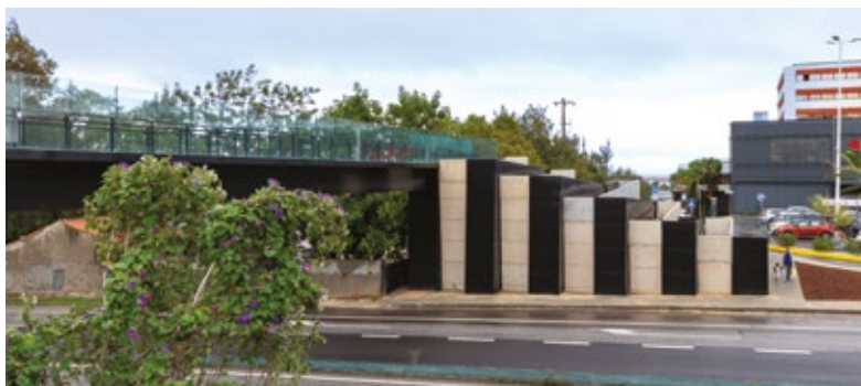
Abertura da Passagem Superior da Malvarosa Investimento: 630 647,00€ (IVA incluído)
