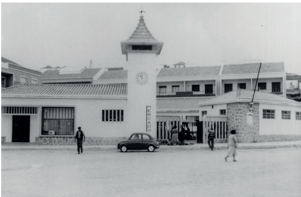
Fig. 12 Novo Mercado Municipal após a sua conclusão, 1958.
