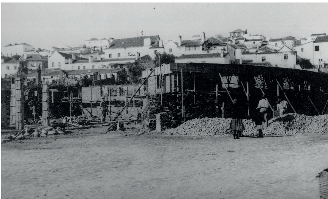
Fig. 11 Início da obra de construção do novo Mercado, 1956.
