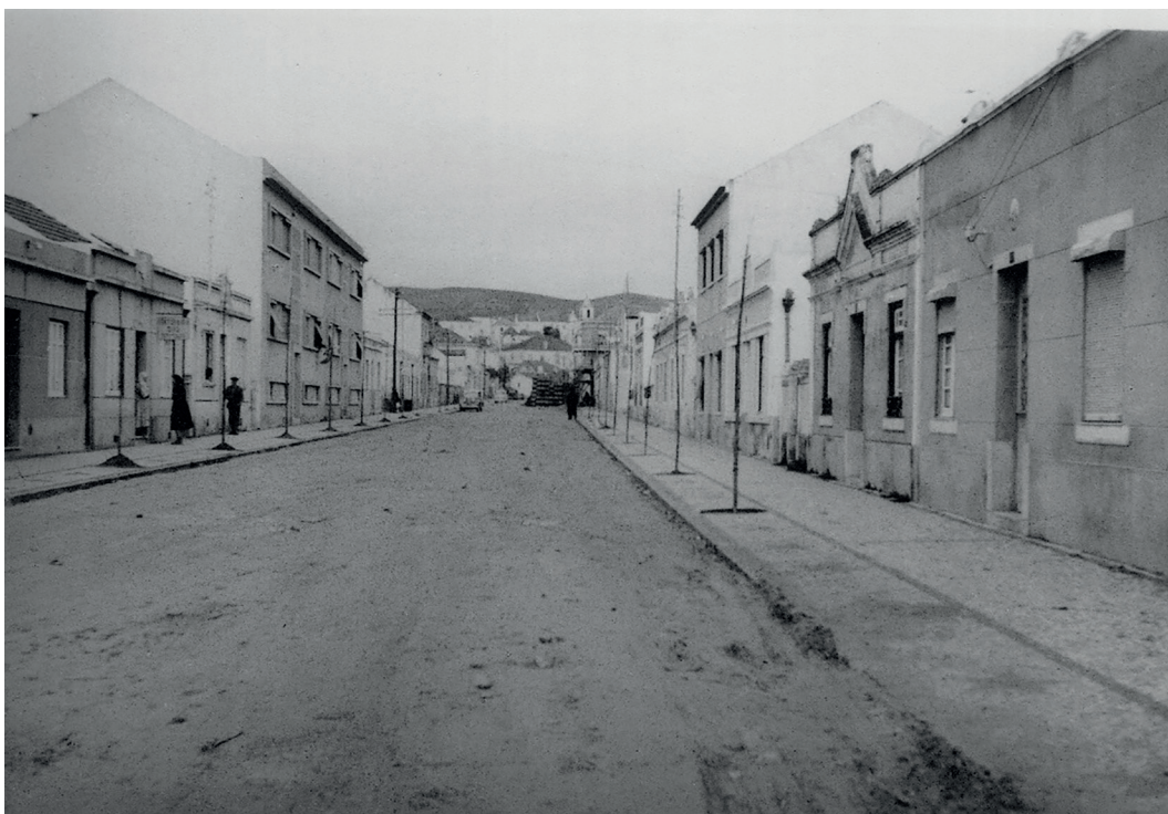
Fig. 6 Construção de passeios na Avenida Capitão João de Almeida Meleças, 1959.
