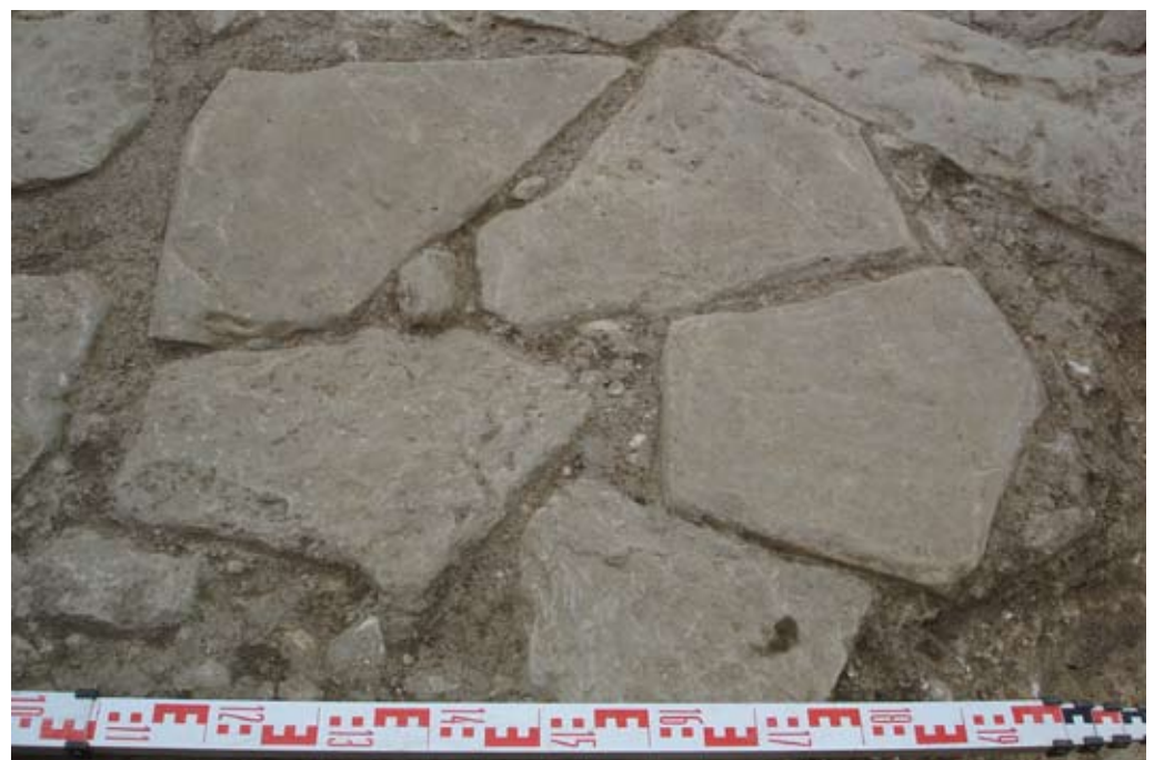
Figura 3 Fotografia de pormenor das lajes da estrada.
