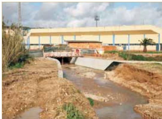
Pontão sobre a Ribeira de St.º António S. João dos Montes
