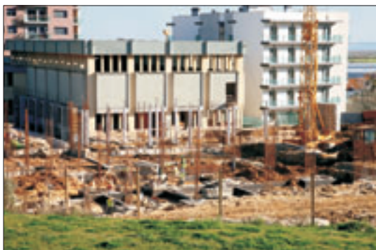
Em Alverca do Ribatejo , desenvolve-se já a construção da Escola EB I JI da Malva Rosa
