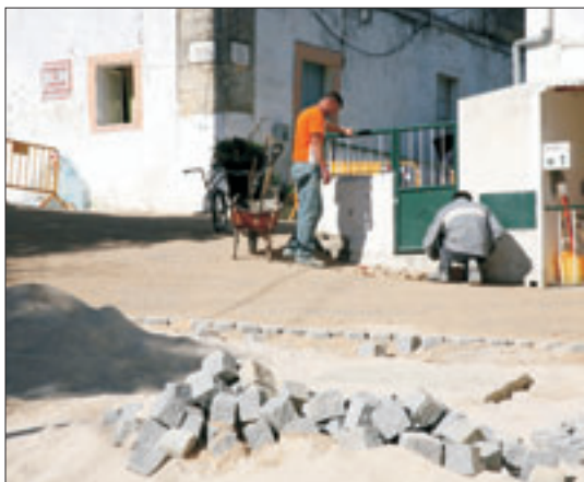
Continua a decorrer a intervenção de requalificação do Largo de Suberra (na imagem substituição de calçadas)
