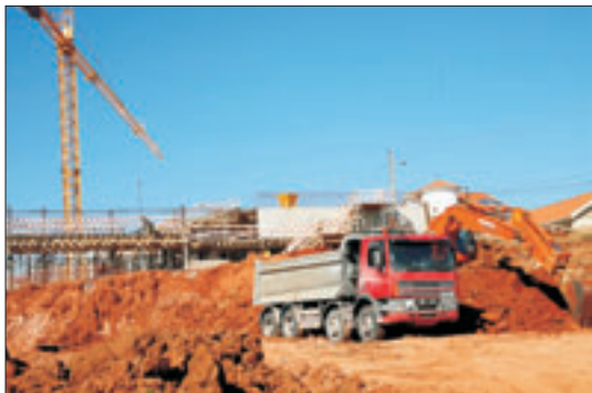
Em desenvolvimento, a construção da Escola EB I/ JI de Vialonga, na Quinta das Índias
