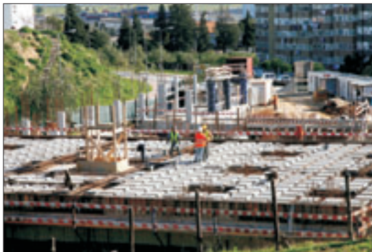
Estão em franco desenvolvimento os trabalhos de Execução das Piscinas Municipais do Forte da Casa
