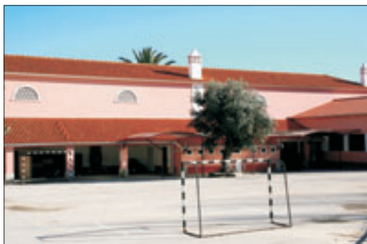
Vai ter início a ampliação da Escola EB I Nº I da Póvoa de Santa Iria , para mais seis salas e áreas de apoio educativo
