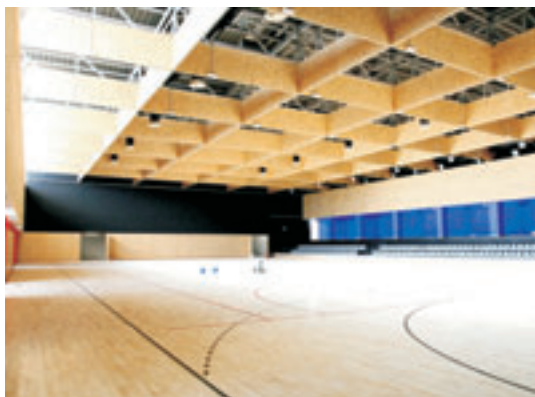
Está praticamente concluído o Pavilhão de Castanheira do Ribatejo , estando em curso os arranjos exteriores ao mesmo
