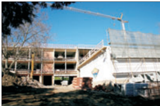
A Escola EB I Sousa Martins, em Vila Franca de Xira , está em obra de adaptação para o 1.º Ciclo
