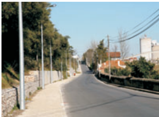
Mais segurança para peões, depois da execução de passeios na Rua da República , Póvoa de Santa Iria
