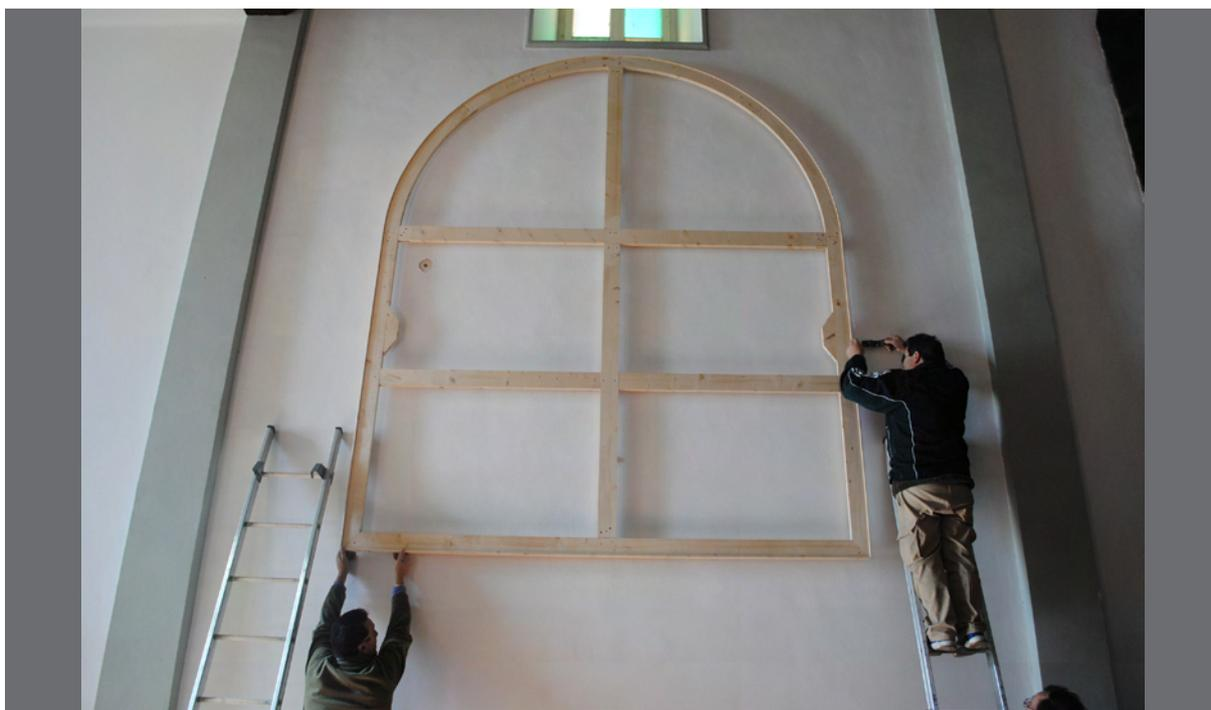
**Fig. 35** - Ensaio da nova grade móvel para colocação dos elementos de fixação na parede. (João Miguel Salgado, 2014).
