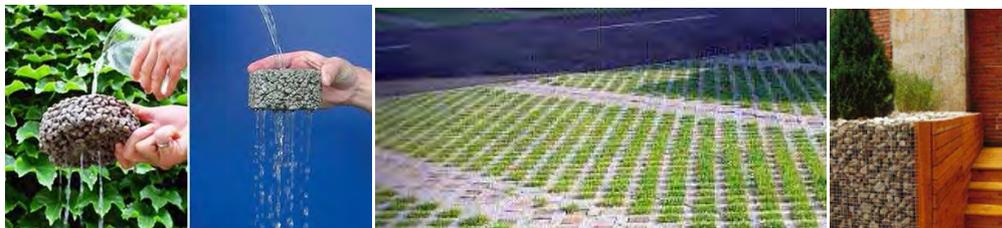
Fig. 119 - Utilização de materiais porosos nos pavimentos<sup>119</sup>
