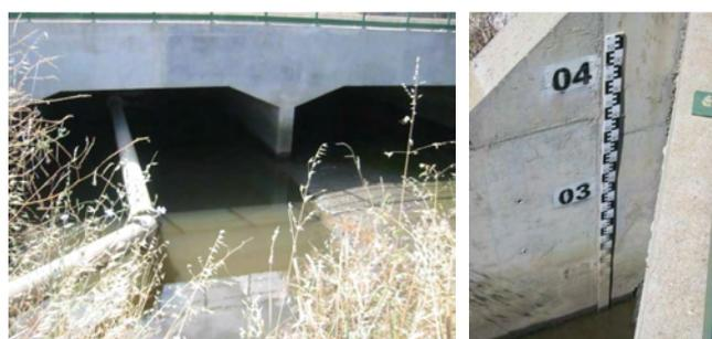
**Fig. 13 - Passagem hidráulica na Vala do Carril e limnógrafo instalado na mesma (Fotografias CMVFX, 2011)**
