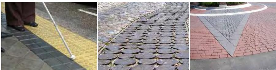
Fig. 108 - Utilização de pavimentos com texturas<sup>107</sup>
