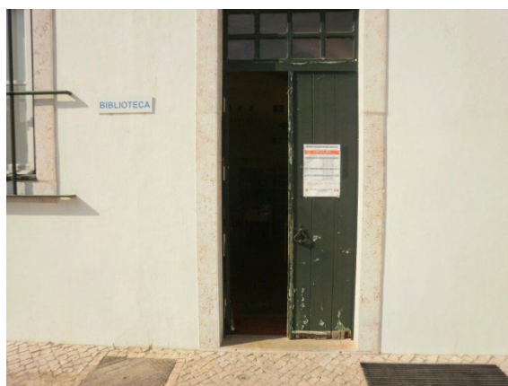
Figura 6.22 Acesso ao Piso Inferior
