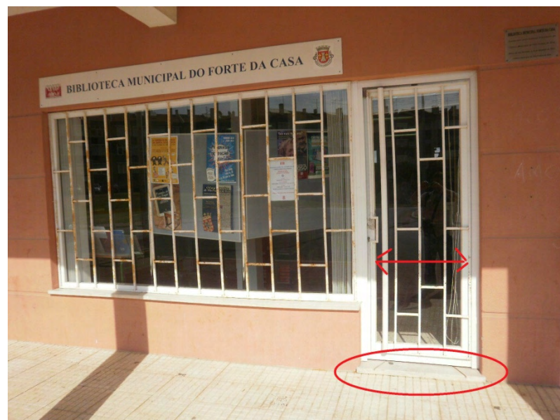
Figura 6.18 Entrada da Biblioteca Municipal – Pólo Forte da Casa
