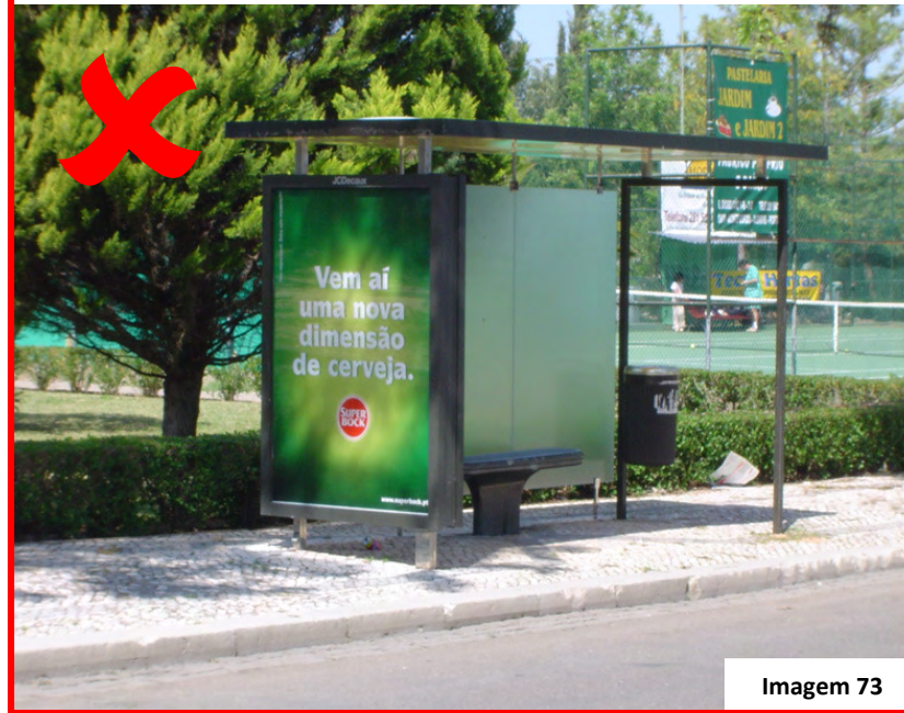
Abrigo que ocupa toda a largura do passeio
