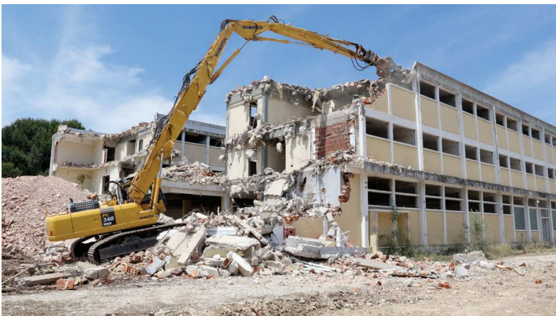
Foto 16 - Demolição de edifícios para as futuras instalações do Tribunal Judicial - VFX
