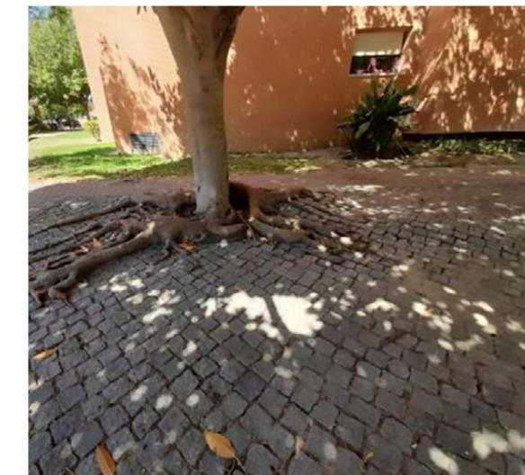
Imagens 19, 20, 21, 22 e 23 - Exemplo de danos nos pavimentos provocados pelo desenvolvimento do raizame.
