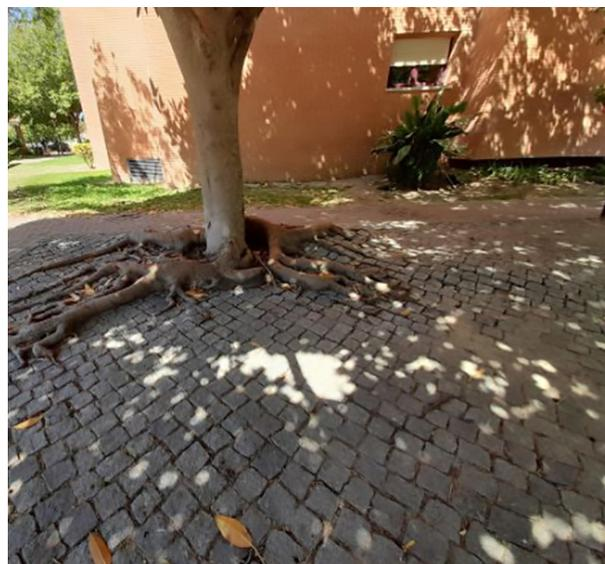
Imagens 19, 20, 21, 22 e 23 - Exemplo de danos nos pavimentos provocados pelo desenvolvimento do raizame.
