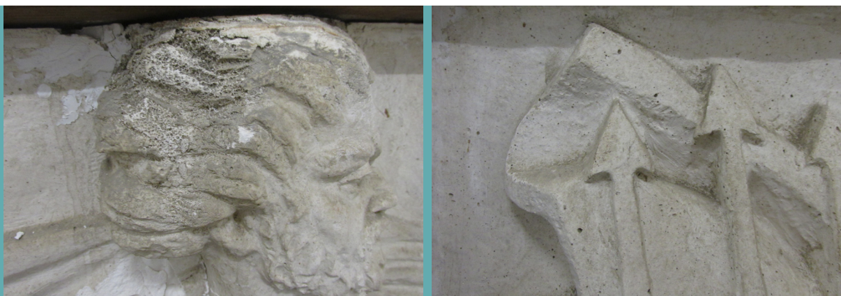
Fig. 20 Alveolização. Foto: Ana Sofia Neves, 2017, CMVFX. Fig. 21 Deposição de Poeiras. Foto: Ana Sofia Neves, 2017, CMVFX.
