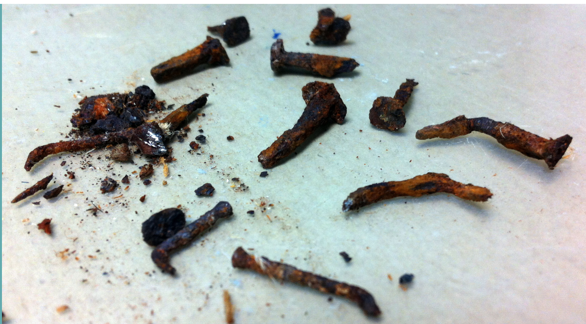
Fig. 16 Elementos metálicos que fixam a tela à grade. Ana Antunes, 2016 ©.
