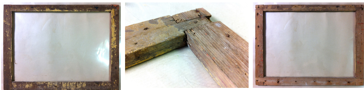
Figs. 13, 14 e 15 Grade e tipo de samblagem. Foto: Ana Antunes, 2016 ©.
