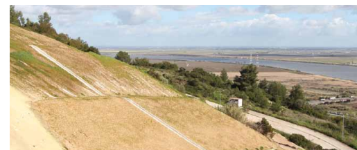
Estabilização do talude da estrada de S. Marcos
