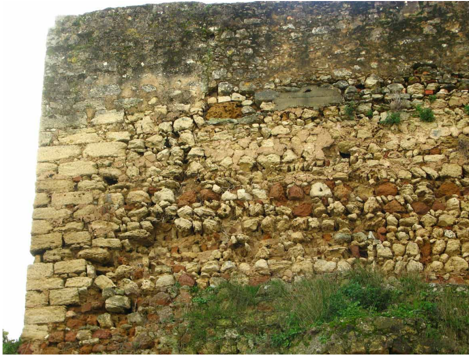
Fig.21 - Observa-se a aplicação desordenada dos blocos de pedra sugerindo que a intenção seria rebocar a parede na íntegra. Foto-Miguel Salgado, 2014.
