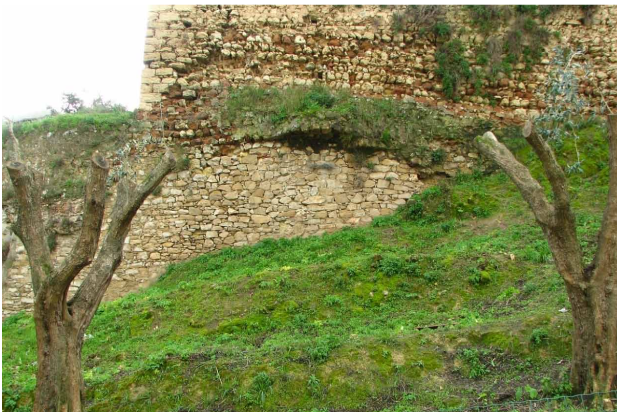
Fig.9 - Aspeto da área envolvente, que carece ser beneficiada. Foto-Miguel Salgado,2014.
