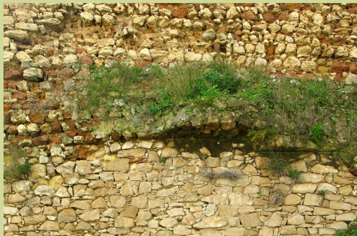
Fig.16 - Uma intervenção antiga que não respeitou as características da construção da muralha mas estabeleceu a sustentabilidade suficiente para evitar a derrocada do elemento superior que sugere o arranque de um pavimento. Foto-Miguel Salgado, 2014.
