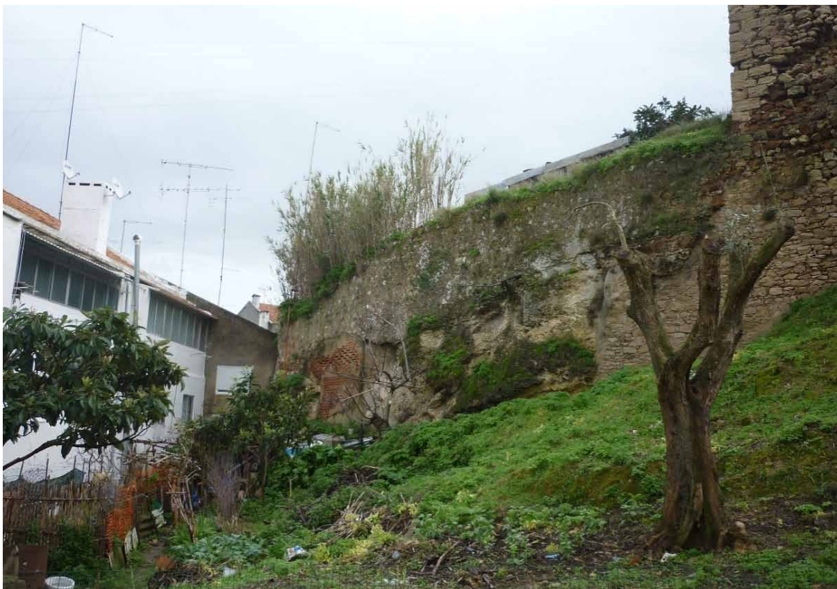
Fig.8 - Aspeto da área envolvente, que carece ser beneficiada. Foto-Miguel Salgado,2014.
