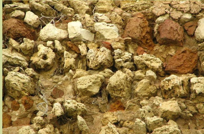
Fig.15 - Neste pormenor da muralha a ação da erosão manifesta-se quer na perda de material quer nos processos de esfoliação e de alveolização da superfície das pedras. Foto-Miguel Salgado, 2014.
