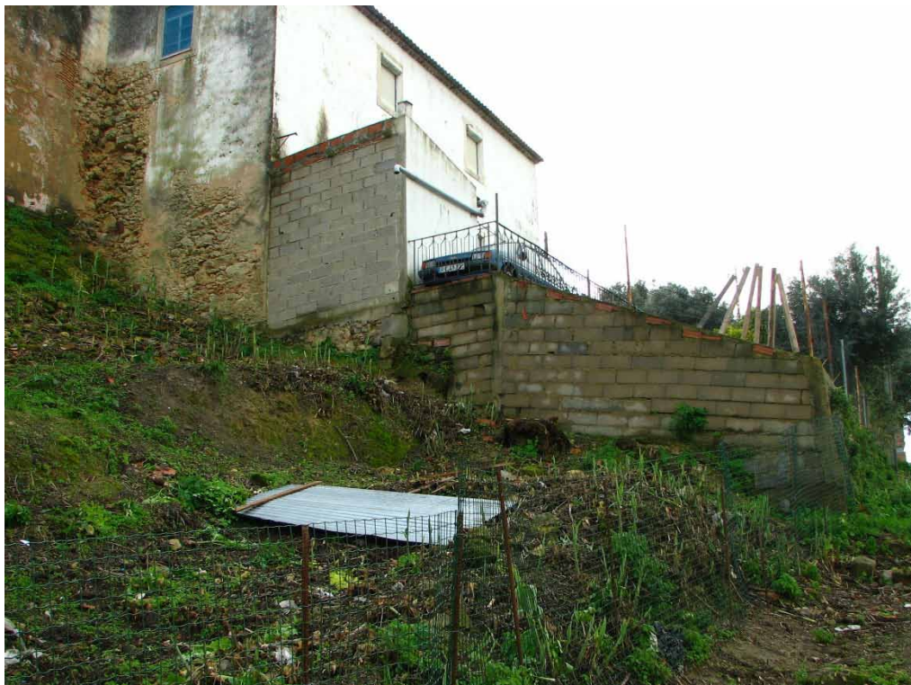
Fig.18 e Fig.19 - Edificações no plano superior da muralha e pequenas construções recentes. Observam-se grandes áreas de lacunas no reboco existente. Foto-Miguel Salgado, 2014.
