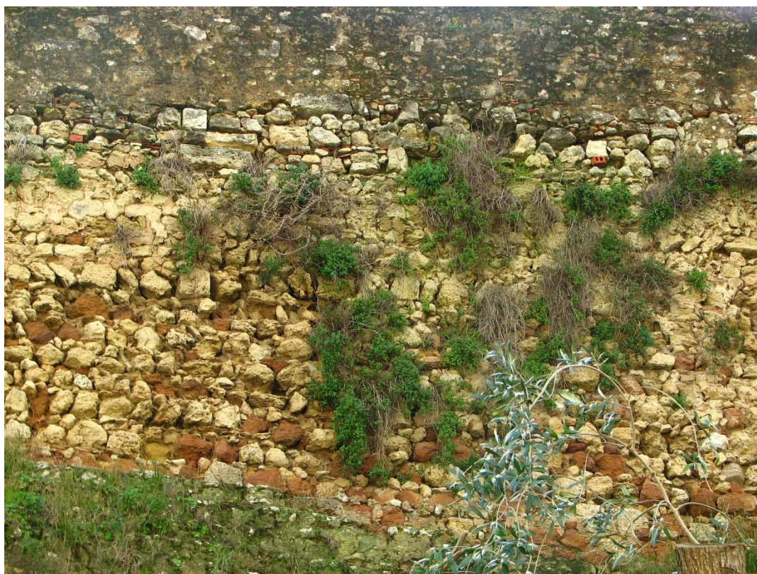
Fig.14 - Aspeto da muralha onde se observa o crescimento de plantas infestantes de porte superior e colonização biológica nos rebocos. Foto-Miguel Salgado, 2014.
