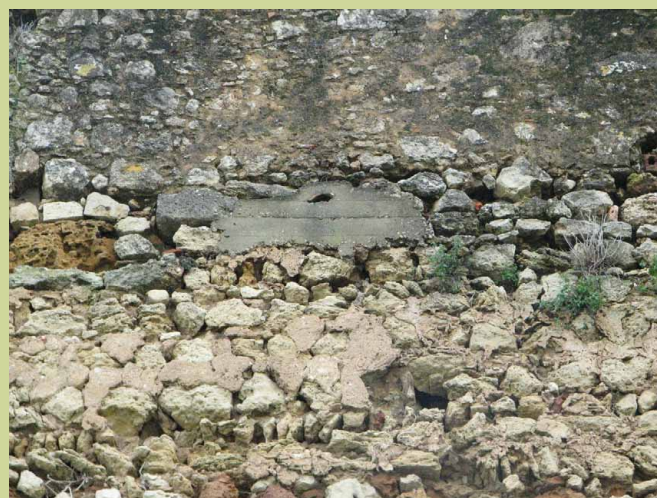
Fig.17 - Aspeto desordenado da superfície da muralha onde se observa uma grande intervenção de consolidação do muro sem respeitar a tipologia de construção existente. Foram aplicadas pedras diferentes e foi usado cimento tipo Portland para preencher vazios na parede. Foto-Miguel Salgado, 2014.
