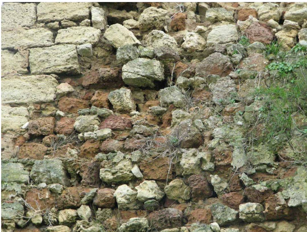
Fig.13 - Pormenor da muralha onde é visível a ausência de juntas entre os blocos de pedra, a perda de material devido à erosão e a presença de colonização biológica. Foto-Miguel Salgado, 2014.
