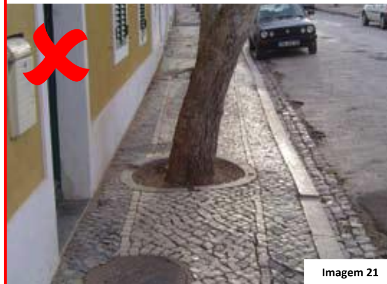
Árvores que impedem a circulação pedonal
