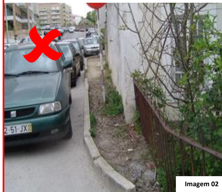
Passeio deteriorado e mal dimensionado
