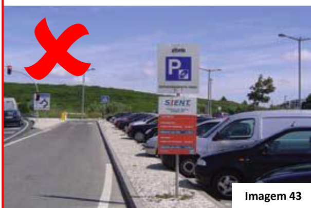
Sinal mal colocado e demasiado baixo
