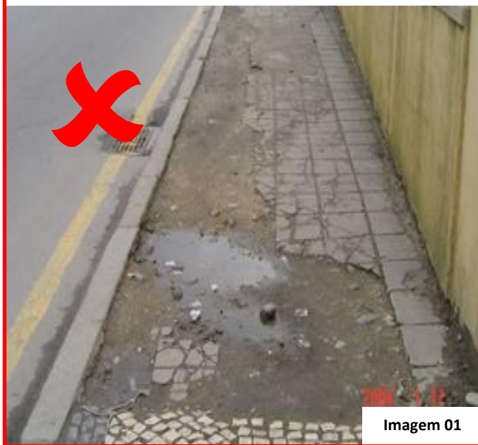
Pavimento degradado e irregular
