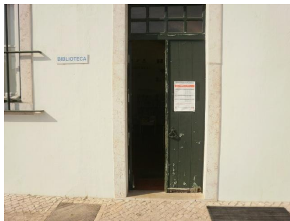
ACESSO AO PISO INFERIOR
